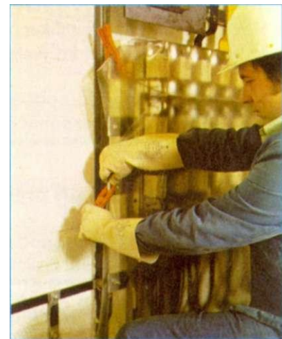
Obr. 2: Zakrytí částí zařízení, které jsou pod napětím
