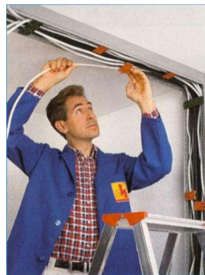
Obr. 3: Ukládání vedení v instalačních žlebech
