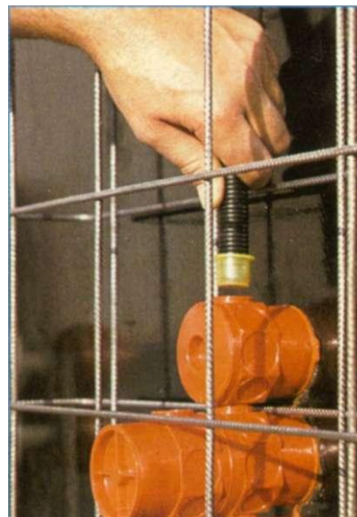
Obr. 1: Instalační trubka s nasazenou těsnící manžetou
