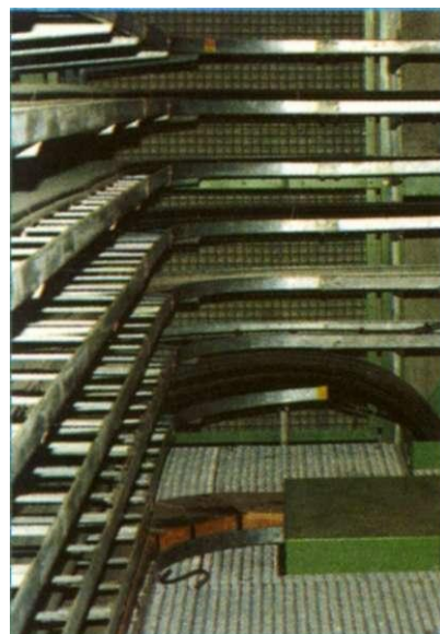
Obr. 2: Instalace vedení na kabelových opěrkách
