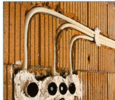
Obr. 1: Instalace pod omítku
