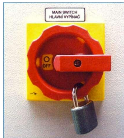
Obr. 1: Hlavní vypínač s funkcí nouzového vypnutí
