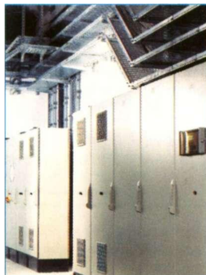
Obr. 3: Instalace vedení v kabelových žlabech
