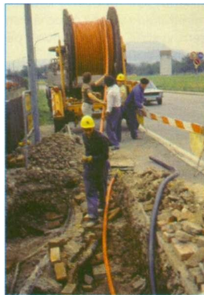
Obr. 2: Pokládání kabelů do země
