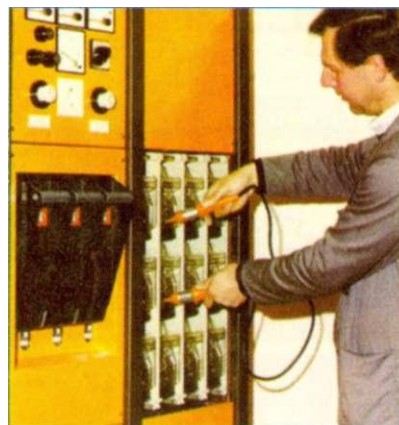
Obr. 3: Přezkoušení beznapětového stavu dvoupólovou zkoušečkou
