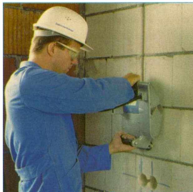
Obr. 3: Frézování drážkovací frézou
